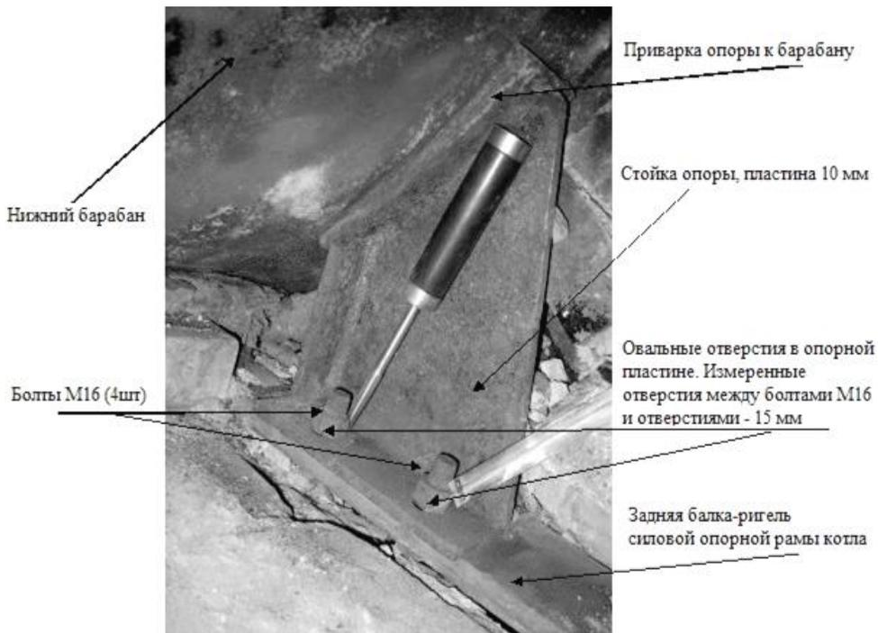
*Рис. 1. Задняя (скользящая) опора барабана котла ДКВР 10-13
