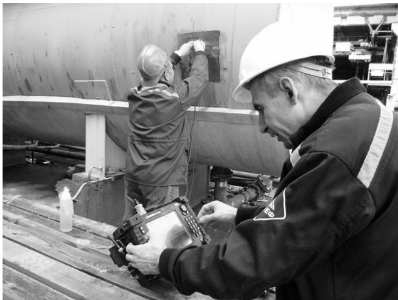
Рис. 1. Наружный и внутренний осмотры, проводимые экспертами по промышленной безопасности
