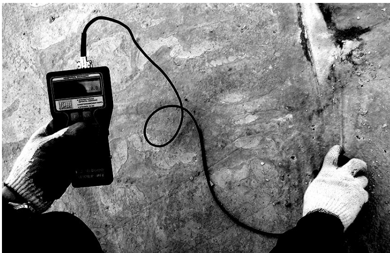
Рис. 1. Обследование зданий и сооружений
