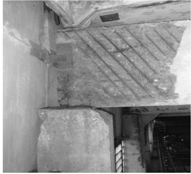
Рис. 1. Дефекты узлов опирания стропильных ферм на колонны
