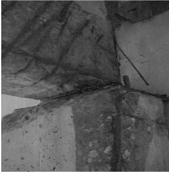
Рис. 1. Дефекты узлов опирания стропильных ферм на колонны
