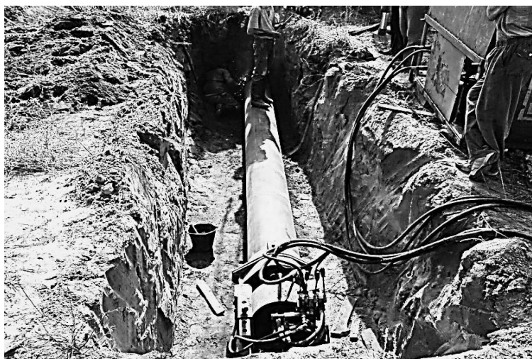
Рис. 2. Буровая установка в котловане
