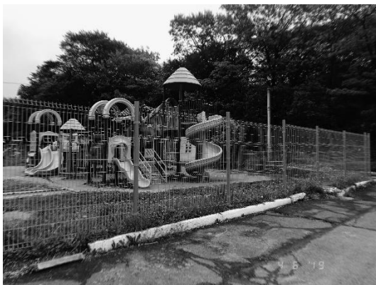
Рис. 2. Разрушенные бордюры детской площадки
