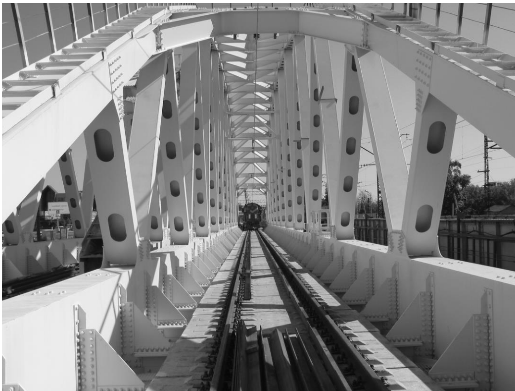
Рис. 3. Безбалластное мостовое полотно
