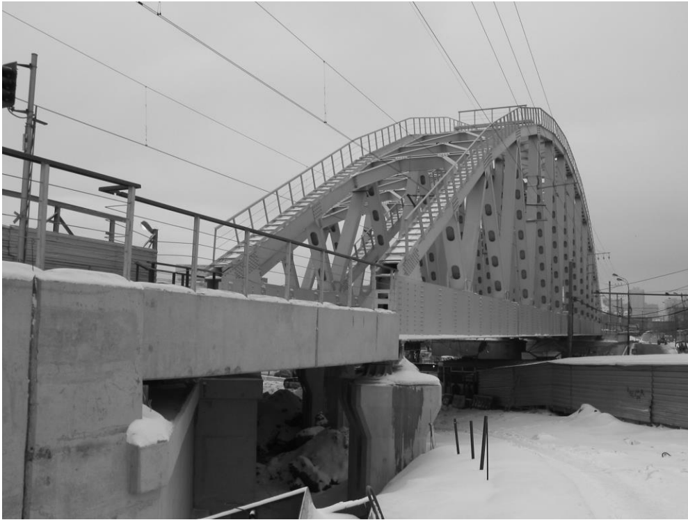
Рис. 4. Переходное плитное железобетонное пролетное строение
