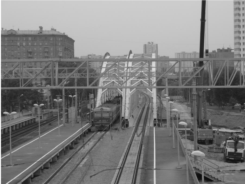
Рис. 1. Общий вид путепровода
