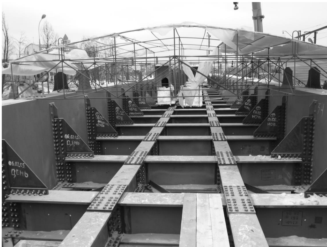
Рис. 2. Узлы соединения поперечных и продольных балок
