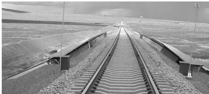
Рис. 1. Солнцезащитные навесы, сооружаемые на грунтовых насыпях
